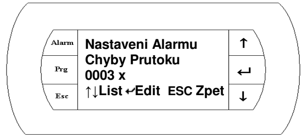
počet chyb průtoku
